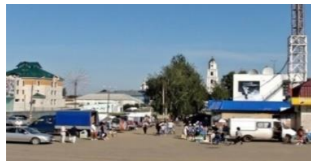
Реконструкция площади, инженерной инфраструктуры канализации
